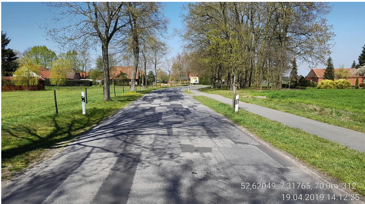
Foto: Teglinger Weg – Höhe südlich K 223 in Richtung Norden
