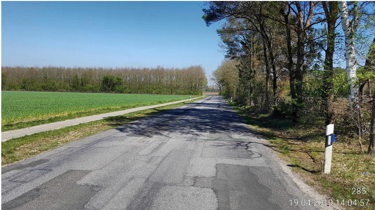
Foto: Gusbergstr. – außerorts in Richtung Nordosten Querschnitt:
