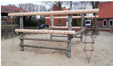
Ludgerischule: Klettergerüst 2018 repariert
