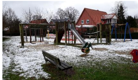
Freskenhof: fehlende Fallschutzflächen
