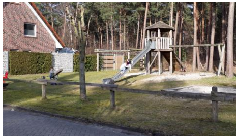
Georgstr.: Reparaturbedarf Klettergerüst, Zaun zu erneuern
