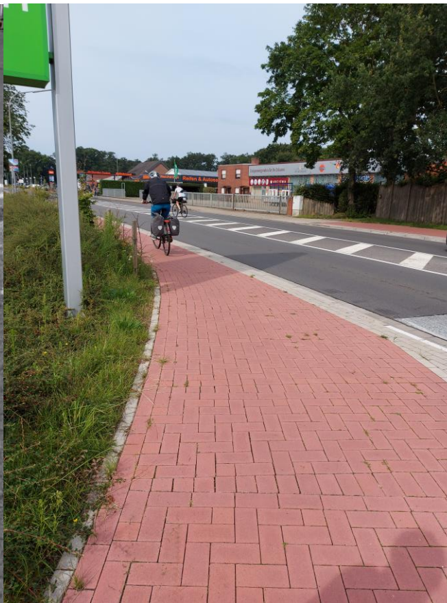
Gestaltung des Pflasters (Foto: Gemeinde Geeste)
